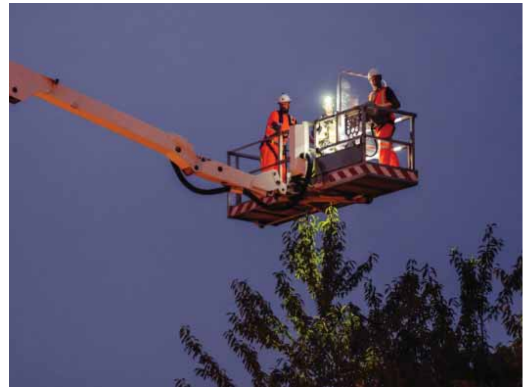
Maintenance du système d'éclairage d'un haut mât
